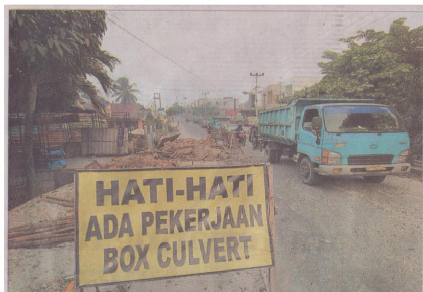
BOX CULVERT: Kendaraan melintas di atas box culvert di Jalan Melati Indah yang terhenti pengerjaannya, Selasa (16/9/2014).
